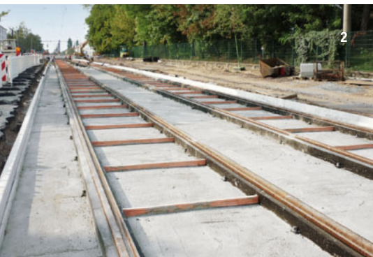
1 Eingedecktes Spurhaltergleis System RAILFLEX/ 2 RAILFLEX nach dem Einbau von Ortbeton/ 3 RAILFLEX-Einbau mit wechselnden Belägen, Magdeburg/ 4 Betoneinbau in Magdeburg/ 5 Spurhaltergleis System RAILFLEX, Cottbus/ 6 Versuchsaufbau am Prüfkörper 2, Hochschule für Technik und Wirtschaft Dresden
